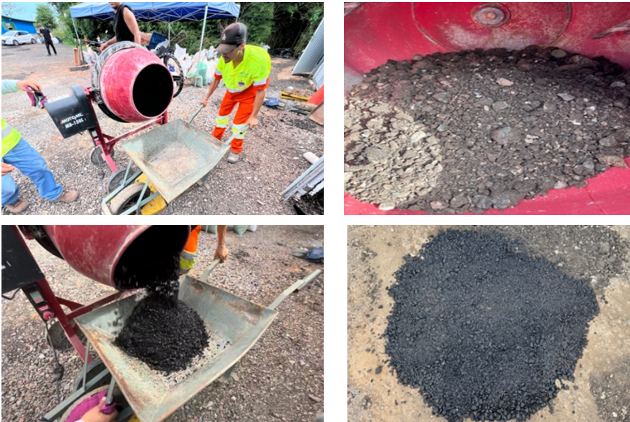
Fotografía 5. Mezcla bituminosa recuperado/ fresado de obra
